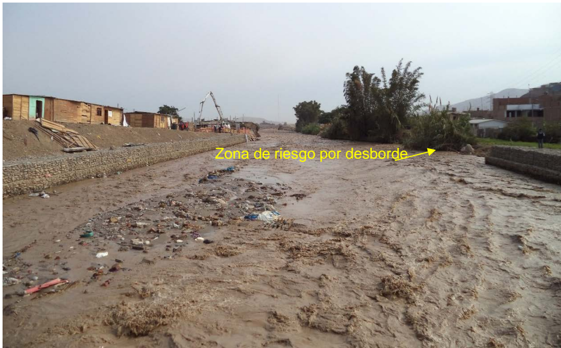
Figura 45. Vista hacia aguas abajo del río. Por evitar la reubicación de las casas, las dimensiones de las secciones de las protecciones de gaviones reducen aún más el ancho del río.
