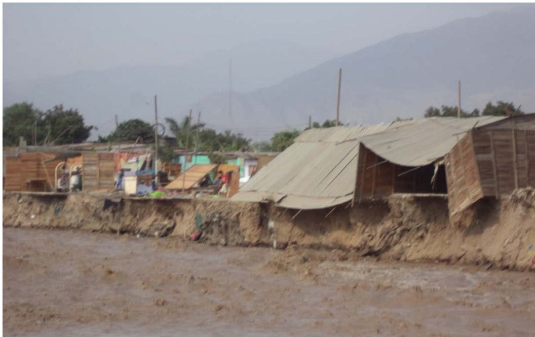
Figura 31. Viviendas colapsadas e inhabitables debido a la erosión de la ladera de la margen izquierda del río Chillón en el P.E-5.
