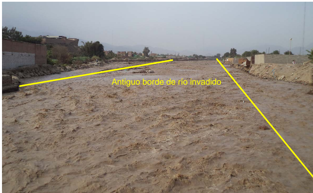
Figura 43. Similar características de problemas encontrados en las zonas urbanas visitadas. Reducción del ancho de río por acumulación de rellenos y con construcciones sobre estas, sin las mínimas condiciones hidráulicas. Vista aguas arriba.
