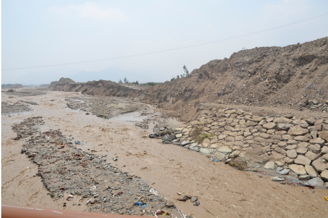
Figura 20. Ladera izquierda del río Chillón protegida por un enrocado.
