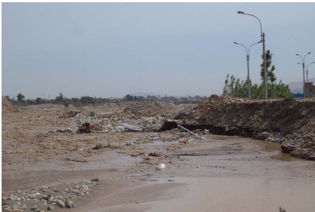
Figura 27. Margen derecha del río Chillón erosionado.
