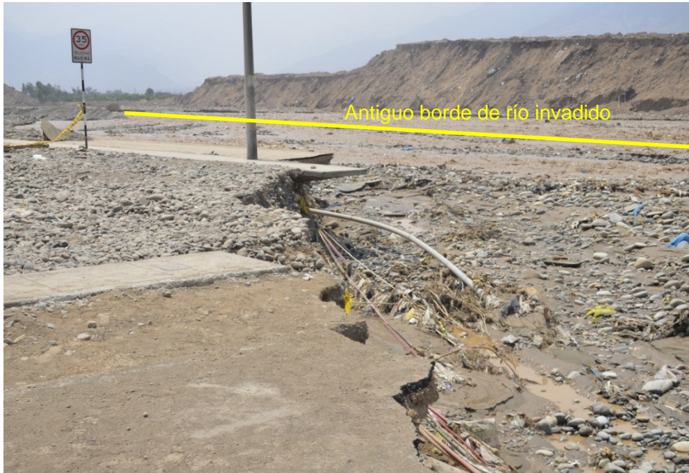
Figura 34. Recuperación natural de cauce del río, vista hacia aguas arriba.
