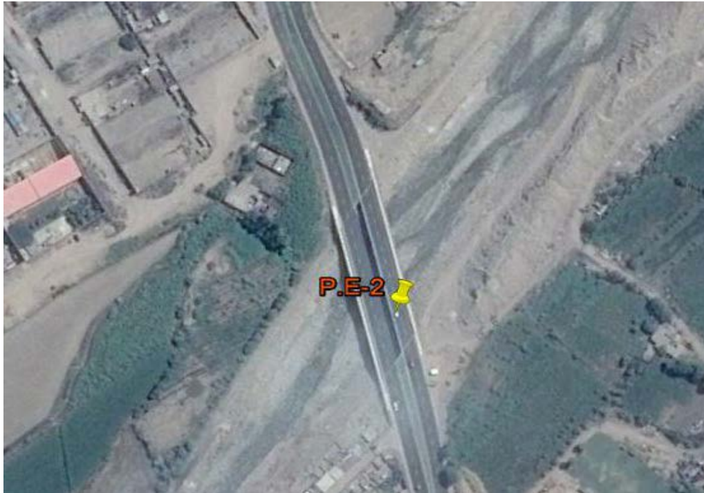
Figura 17. Ubicación del punto de evaluación P.E-2 localizado sobre el Puente San Martín.
