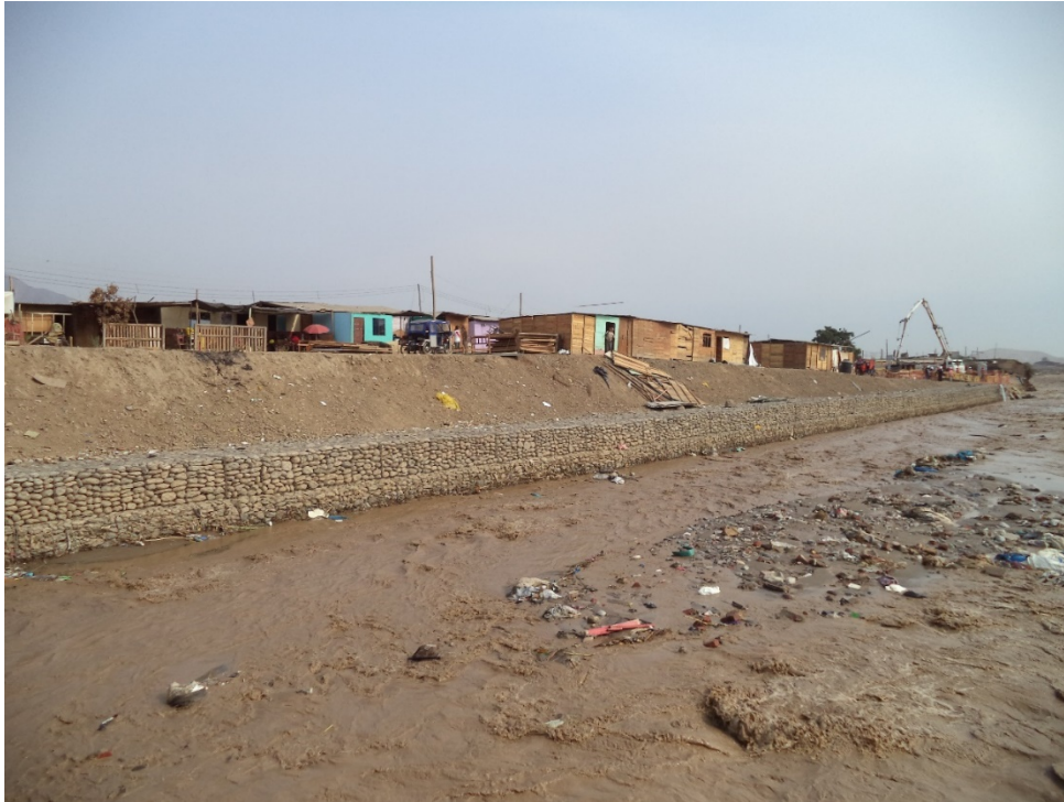
Figura 32. Ladera de la margen izquierda del río Chillón protegida por una geomembrana y gaviones.
