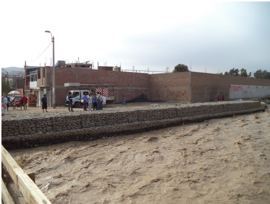
Figura 33. Ladera de la margen derecha del río Chillón, protegida con geomembrana y gaviones.
