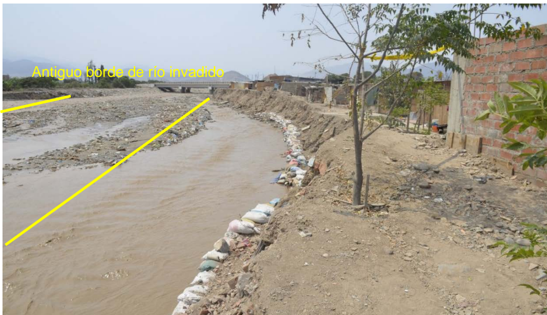
Figura 39. Vista aguas arriba. El río ha erosionado el material de relleno de la margen izquierda, sobre las cuales se han asentado varias viviendas que han sido destruidas. La protección temporal con sacos de arena no garantiza el progresivo avance del río de presentarse nuevas avenidas.
