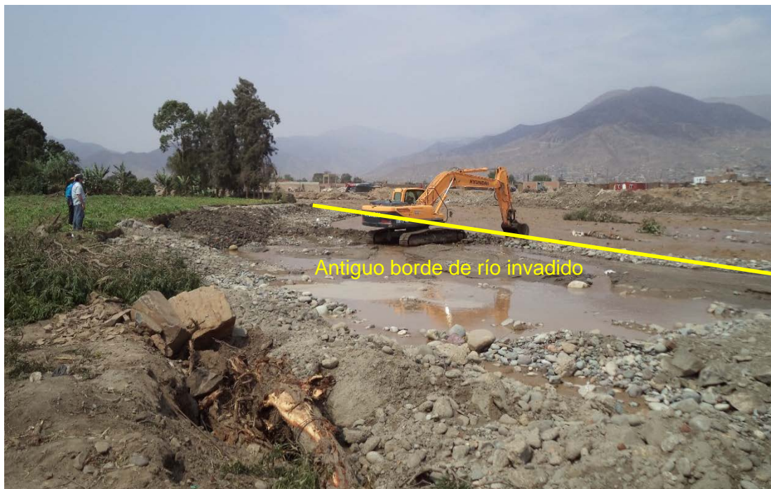
Figura 41. Vista aguas arriba. La protección con acumulación de material propio de lecho de río, corre el riesgo de nuevamente ser transportado por el paso de nuevas avenidas.
