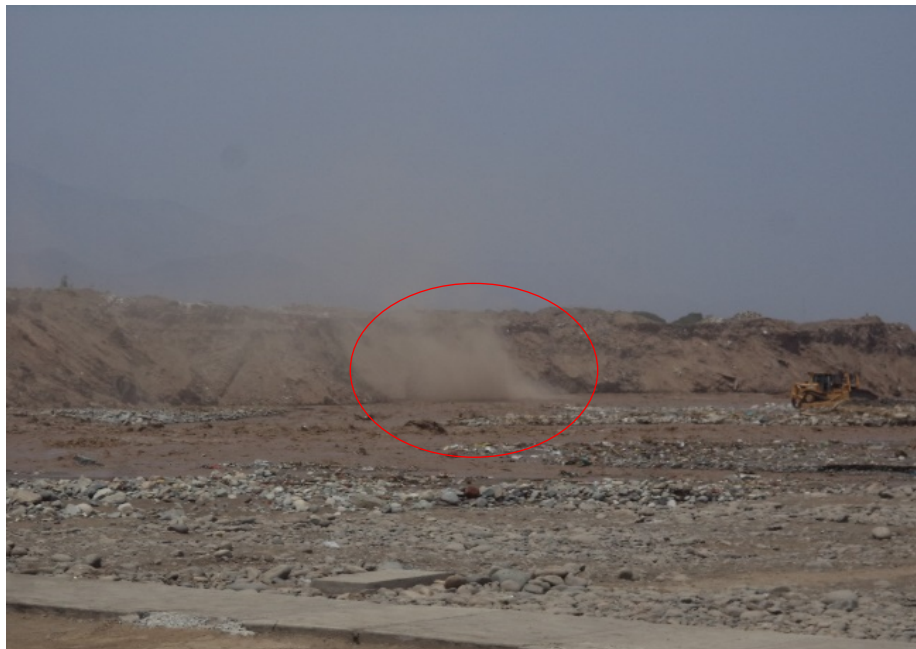
Figura 14. Ladera del margen izquierdo del río Chillón, constituido por material de relleno, de 20m aprox. En la figura puede observarse una polvareda generada por el deslizamiento de material de la ladera, el cual es originado por la fuerza del agua de río que erosiona del pie de la ladera (erosión fluvial).
