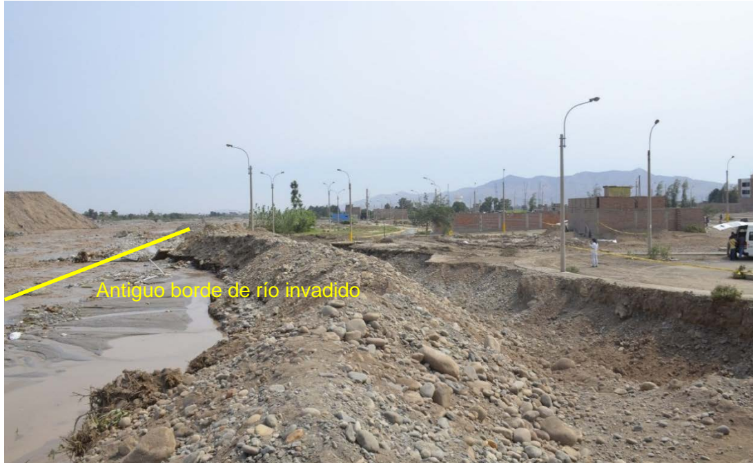
Figura 42. Otra vista de la margen derecha de río, con las protecciones con material de lecho, parte de la urbanización que ha ocupado el cauce ha sido destruida.
