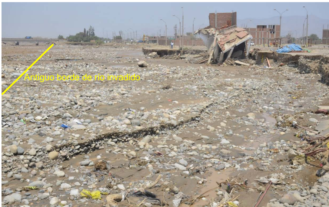
Figura 35. Vista hacia aguas abajo de la erosión de la margen derecha del río Chillón. La diferencia de nivel del fondo de río y el terreno adyacente es en promedio 1.4 m.
